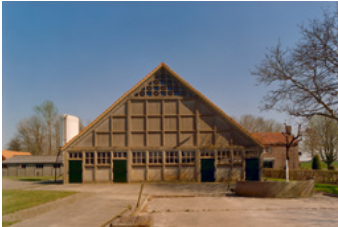
Standaardschuur in de Noordoostpolder, gebouwd door de firma Schokbeton in Kampen.
