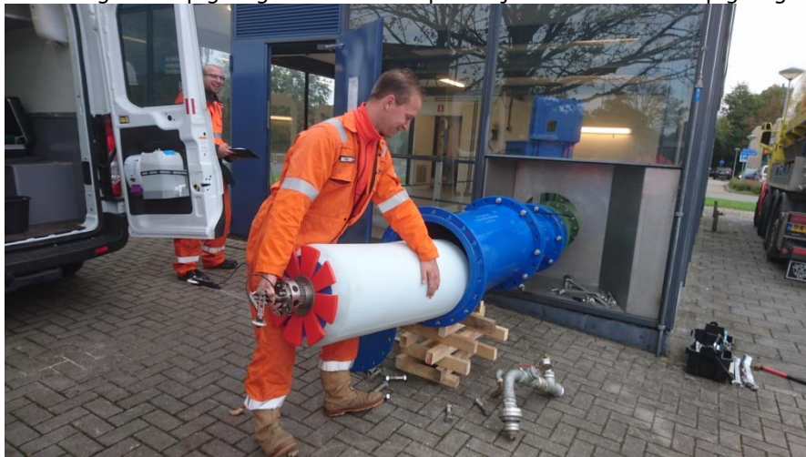
De intelligent pig wordt gehesen in een persleiding
