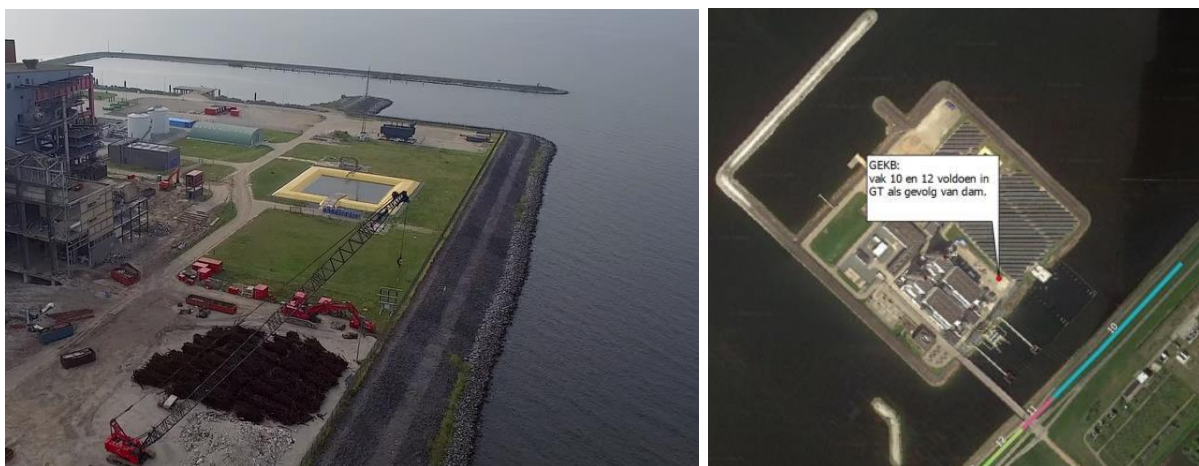
Figuur 4-8: Oostzijde Maximacentrale en bovenaanzicht.
