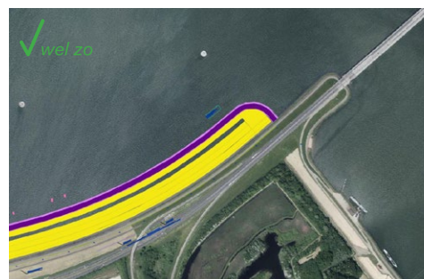
Afgerond eindpunt vooroeverdam bij Ketelbrug (Bron: RHDHV)
