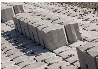
Opstaande zuilen in het zetsteentalud ter voorkoming van ongewenste betreding van voertuigen.
