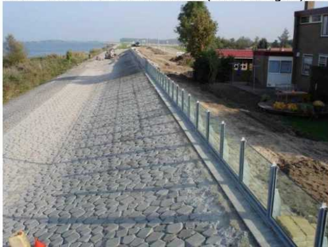
Afbeelding 2.3. Glazen keerwand bij Ketelhaven
