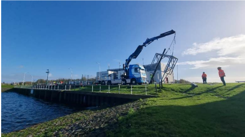
Figuur 25 plaatsing van de frames voor de beluchters en zuurstofmeting gemaal De Blocq van Kuffeler
