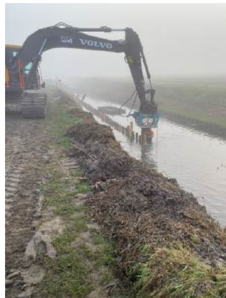
Figuur 27 Aan de slag met gecreosoteerde oeverbeschoeiingen
