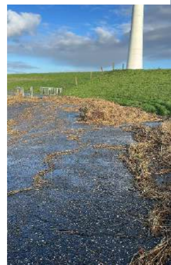
Figuur 12 Vloedmerk na storm op Westermeerdijk, november 2024
