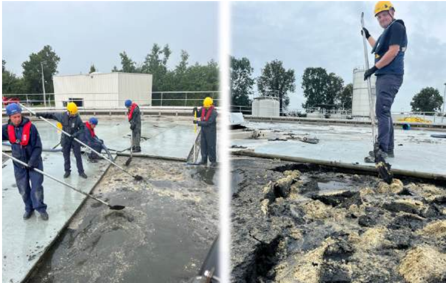
Figuur 29 Vetophoping voorbezinktank AWZI Tollebeek
