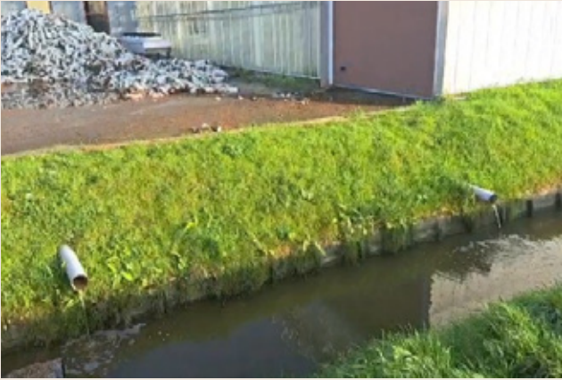
Tijdelijke opslag van substraatmatten op verhard terrein en lozing van afvalwater via straatkolken en afvoerbuizen in het oppervlaktewater. (bron: Hoogheemraadschap van Delfland)
