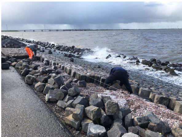
Figuur 5 Steenzetwerkzaamheden vallen onder het reguliere onderhoud van waterkeringen
