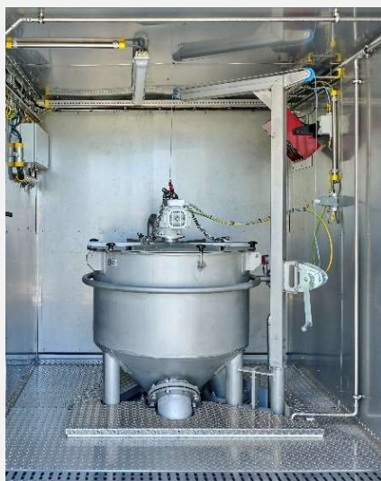
Figuur 24 Fijnzeef waarmee cellulose wordt teruggewonnen uit influent
