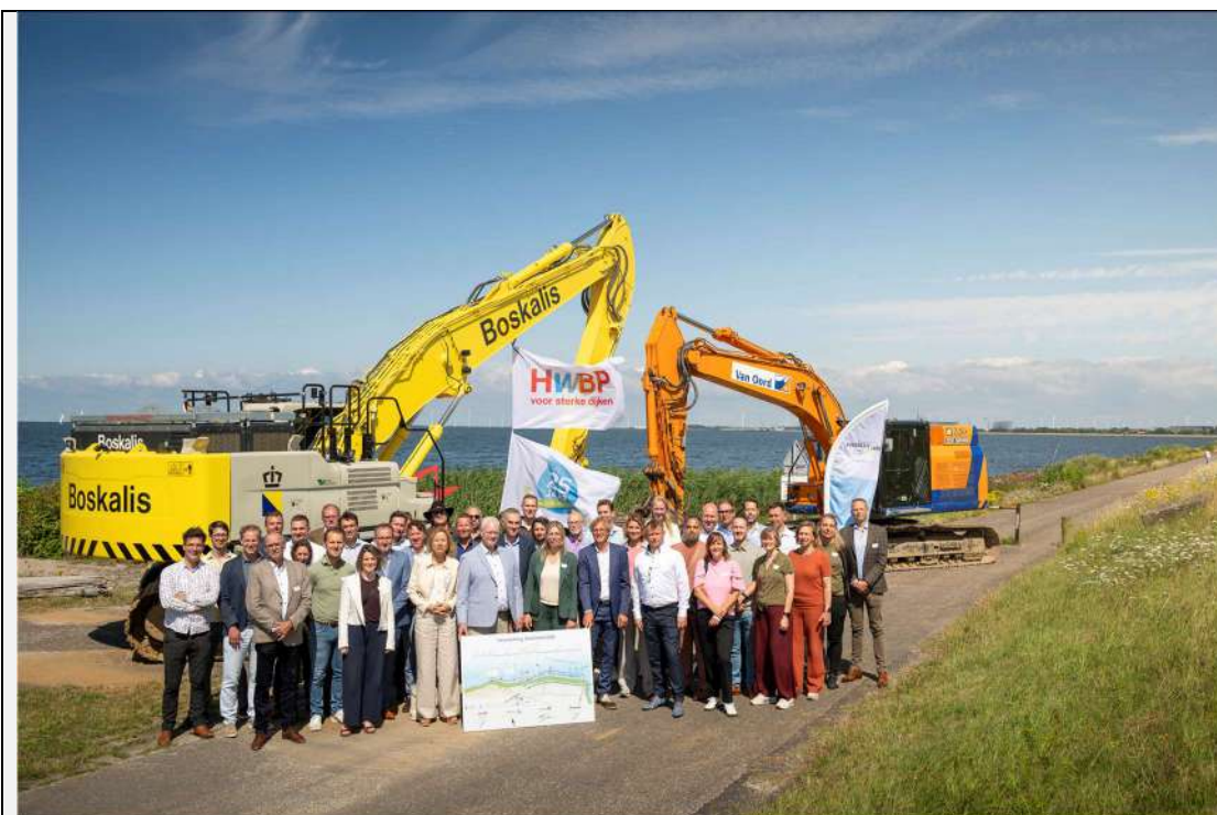
Figuur 13 Start realisatiefase versterking IJsselmeerdijk in het kader van het Hoogwaterbeschermingsprogramma
