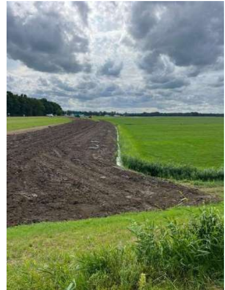
Figuur 17 Grond die vrijkomt bij aanleg duurzame oevers wordt gebruikt op onderbeloop van waterkeringen.
