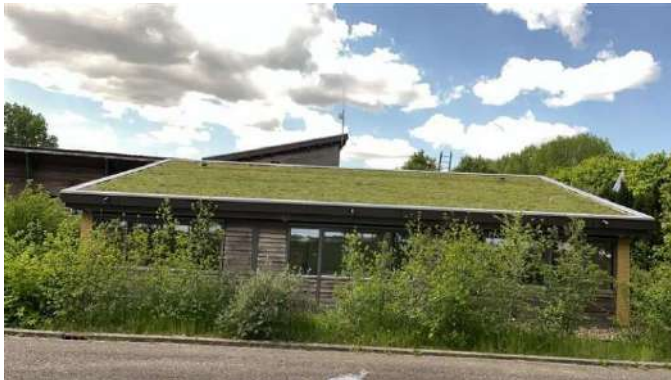
Figuur 36 Energieneutraal kantoor Larserbos
