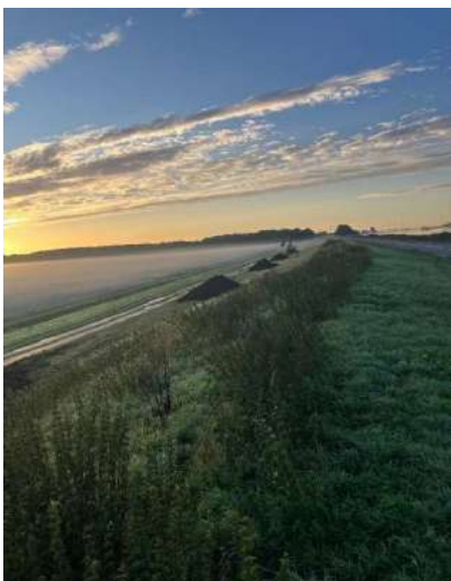
Figuur 9 Aanbrengen grond Eemmeerdijk
