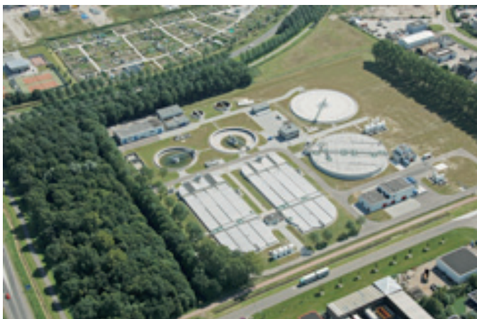
Bron 1 De afvalwaterzuiveringsinstallatie in Lelystad
